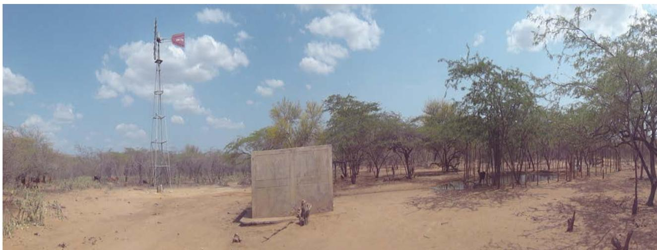
Molino de viento para bombear agua del pozo subterráneo, y llenar así el tanque de almacenamiento hecho de cemento. El agua de pozo y tanque abastece a las comunidades aledañas. Media Guajira.
