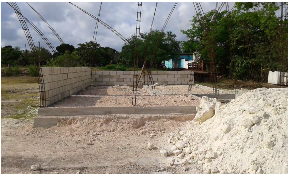
Primeras dos paredes, pegado de block, 2016.
