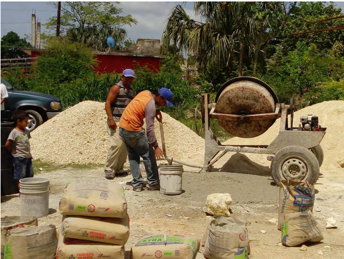
Mezcla para el relleno de castillos de la casa de salud, 2016.
