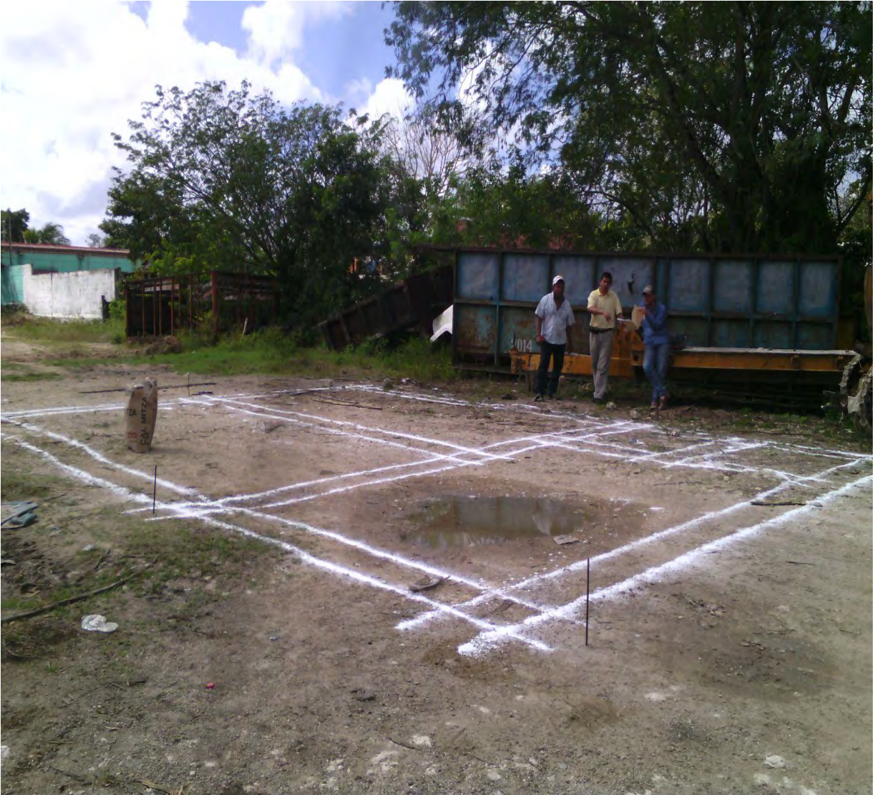
Conclusión de la marcación de la casa de salud, 2016.
