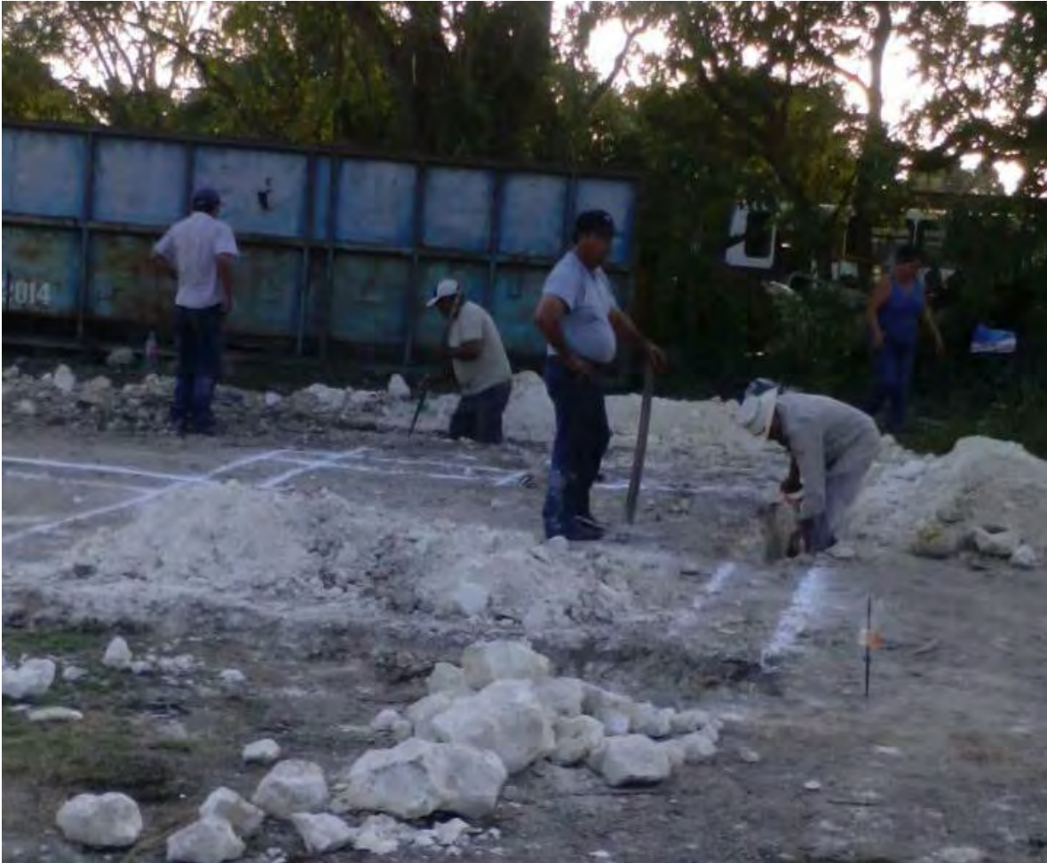
Continuación de la excavación, 2016.
