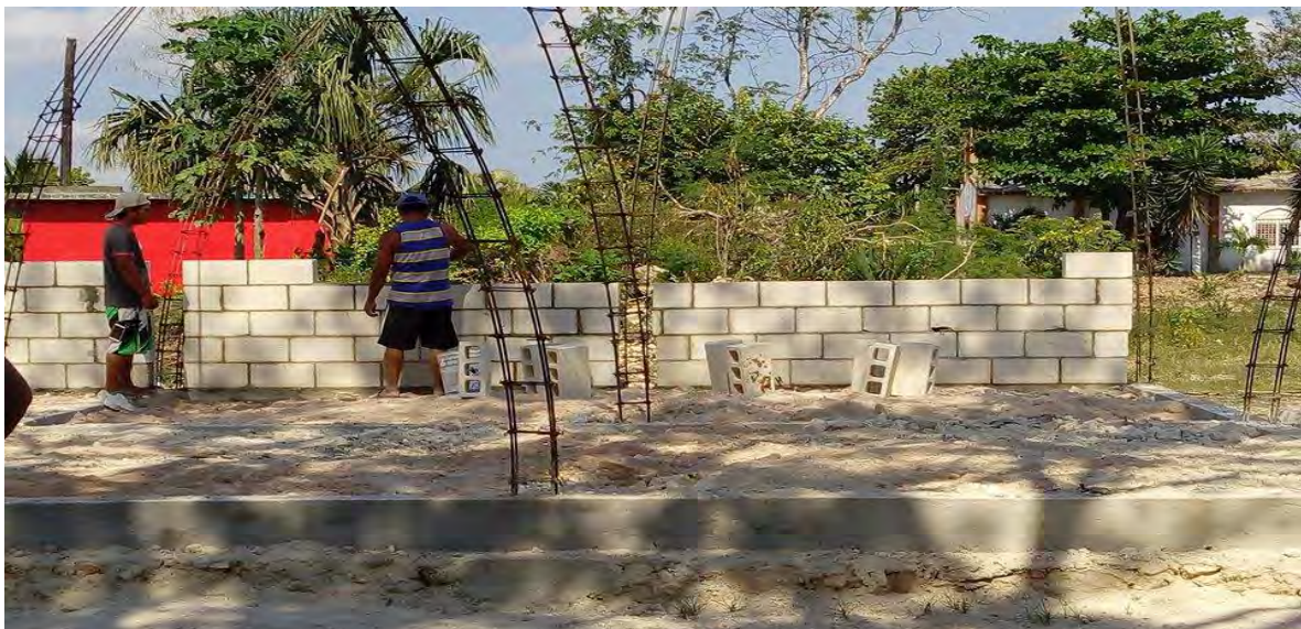
Colocación de los primeros blocks, 2016.
