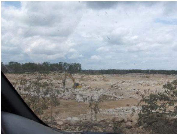
Figura 2.8 Rotura de roca de sobretamaño
