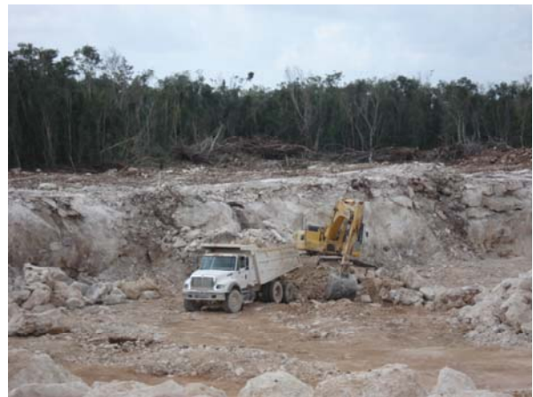
Figura 2.9 Carga y transporte de material
