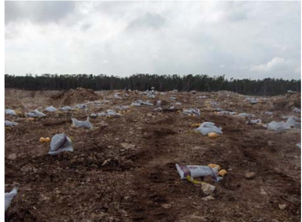
Figura 2.7 Carga de barrenos para voladura
