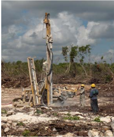
Figura 2.6 Trazo y barrenación de plantilla
