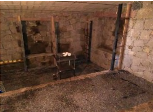
Foto 37. Cava de maduración
