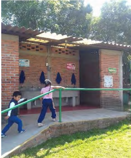
Fotografía 3.8 Rampa de acceso a los sanitarios de Granja Tío Pepe
