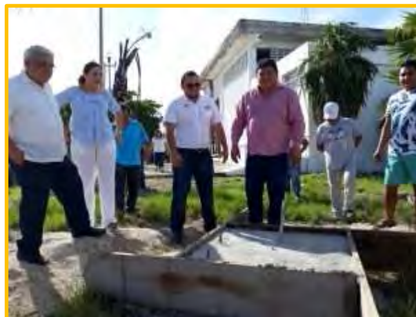
Ilustración 18 - Base de concreto armado
