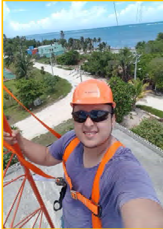
Ilustración 41 - Instalación de la antena en la torre Xcalak
