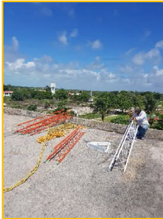
Ilustración 21 - Pintura de los tramos
