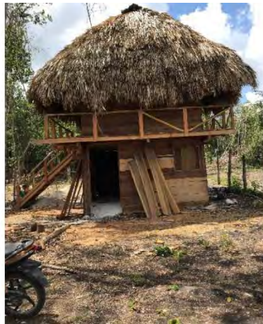
Ilustración 13.- Construcción de guano. Elaboración propia.
