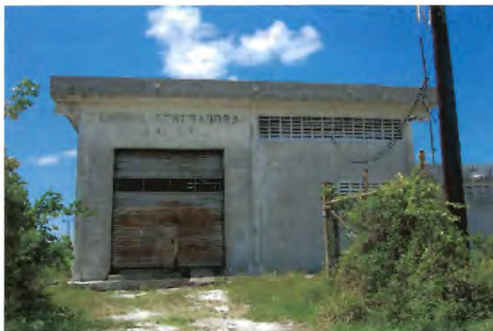
CENTRAL DE GENERADORA DE ELECTRICIDAD POR DIESEL
