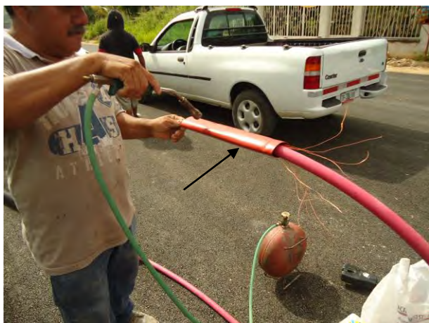
Fig. 3.5 Terminales tipo exterior de 15 kV.
