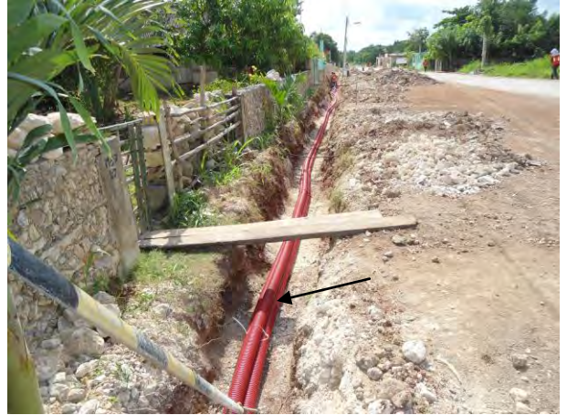
Fig. 3.23 ducto PAD de tres vías
