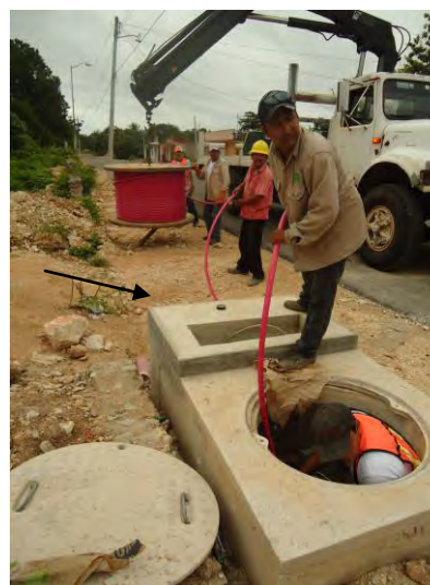
Fig. 3.15, cable XLP-133, 3/0 para 15 KV
