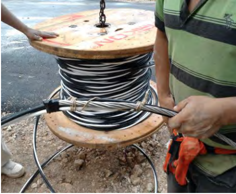
Fig. 3.26 Cable XLPE para baja tensión.
