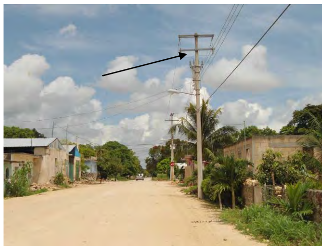
Fig. 1.6 en este poste en la cual se realizara la interconexión de la nueva línea subterránea.
