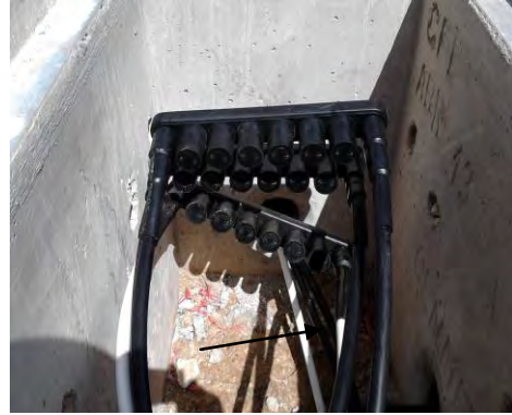
Fig. 3.27 Cable XLPE para baja tensión.
