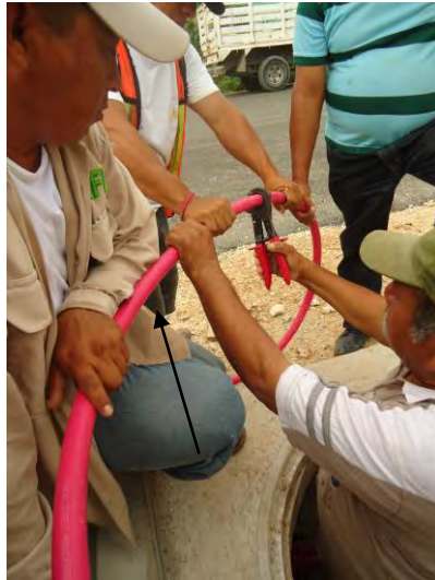
Fig. 3.16 cable XLP-133, 3/0 para 15 KV
