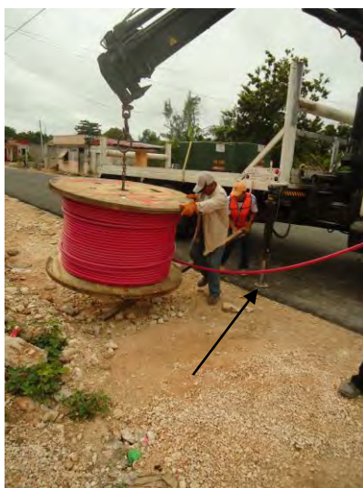
Fig. 3.14, cable XLP-133, 3/0 para 15 kV
