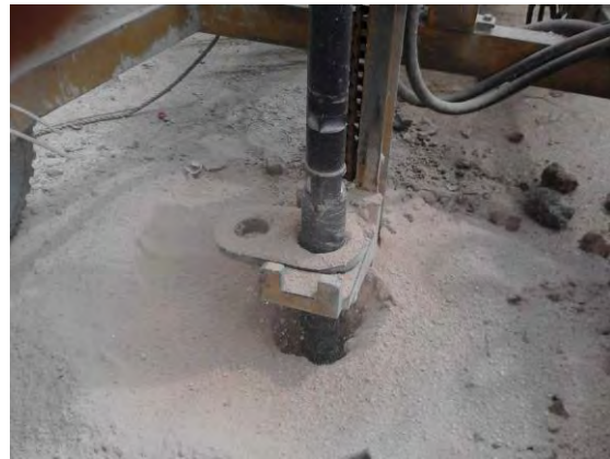
Fig. 3.20 perforación de pozo
