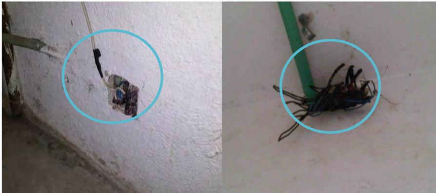
No deben existir conductores eléctricos sin canalizaciones o descubiertos como se muestra en las imágenes además de que no están identificados mediante el código de colores. La sección de la NOM que incumplen es:
