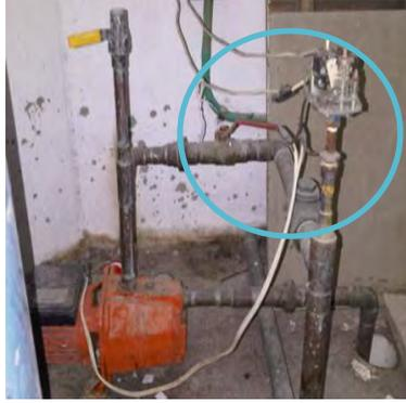
Los conductores deben protegerse en la tubería adecuada para evitar daños
