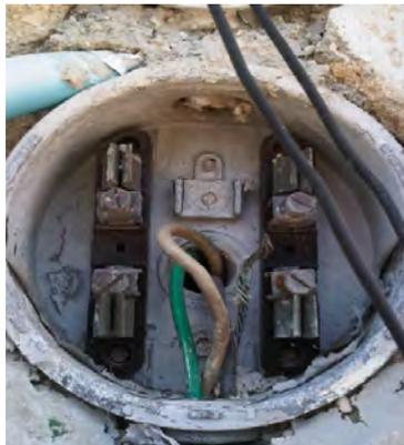
El cable de puesta a tierra debe de estar conectado para evitar accidentes, en la imagen se observa que el cable está desconectado desde la acometida esto incumple con el artículo
