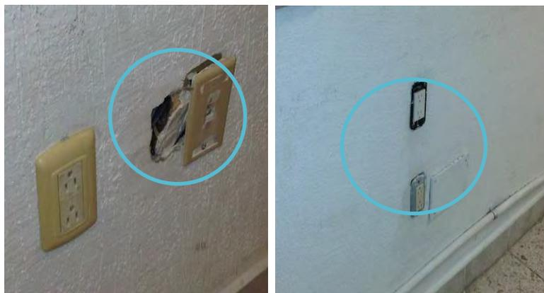
Los contactos deben tener una correcta instalación todas las cajas deben tener una tapa, una placa de cierre o una tapa ornamental de acuerdo con la NOM en la sección:
