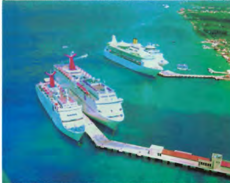
Imagen 2. Terminales Internacionales de cruceros: Puerta Maya y TMM
