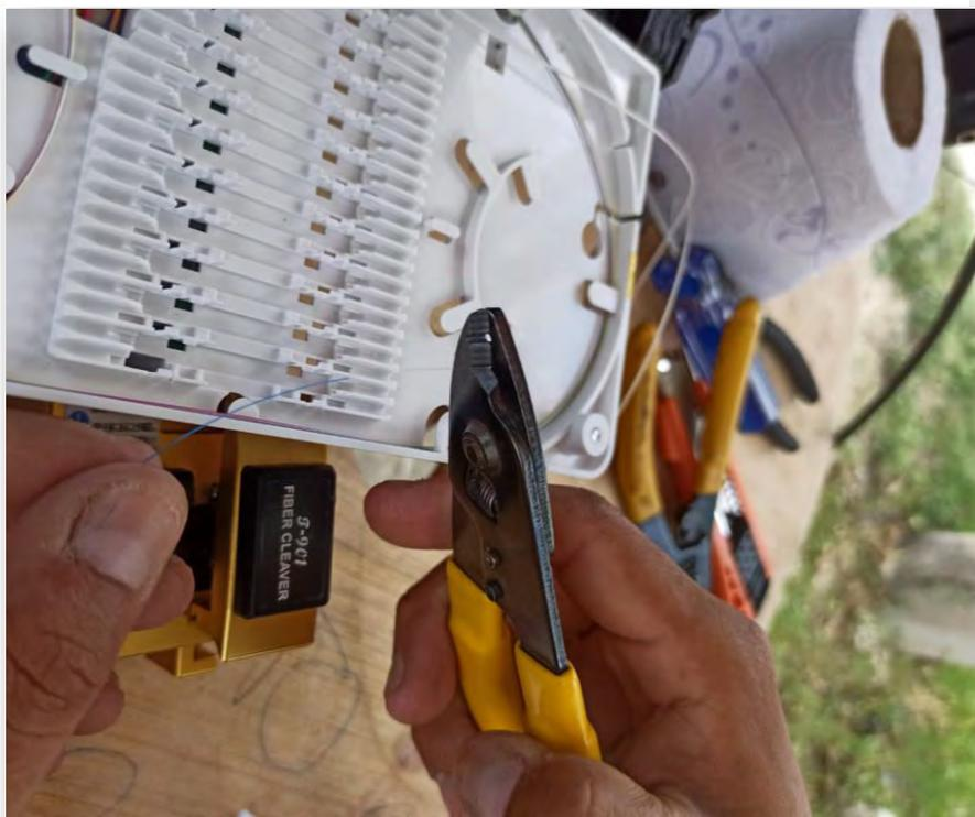
FIGURA 83(PELADO DEL HILO A FUSIONAR)
