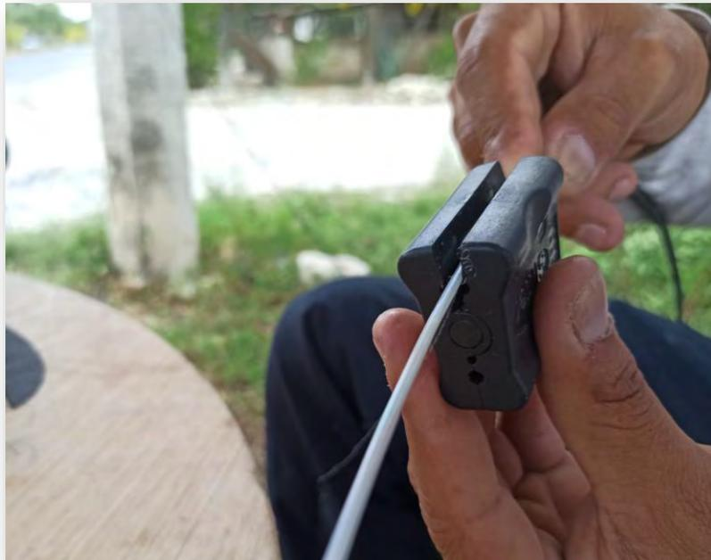
**FIGURA 75(PELADO DEL BUFFER QUE CONTIENE LOS HILOS)**
