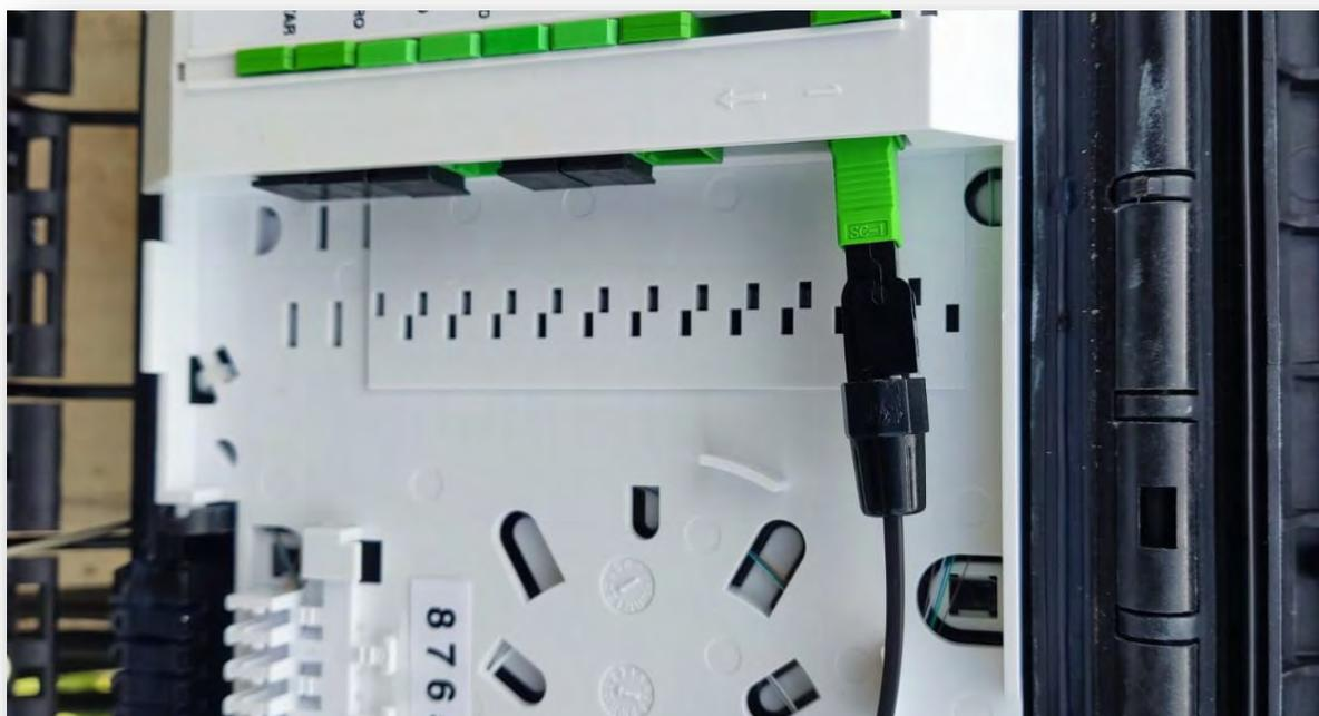
FIGURA 134(CONEXIÓN REALIZADA A LA CAJA DE DISTRIBUCIÓN 2)
