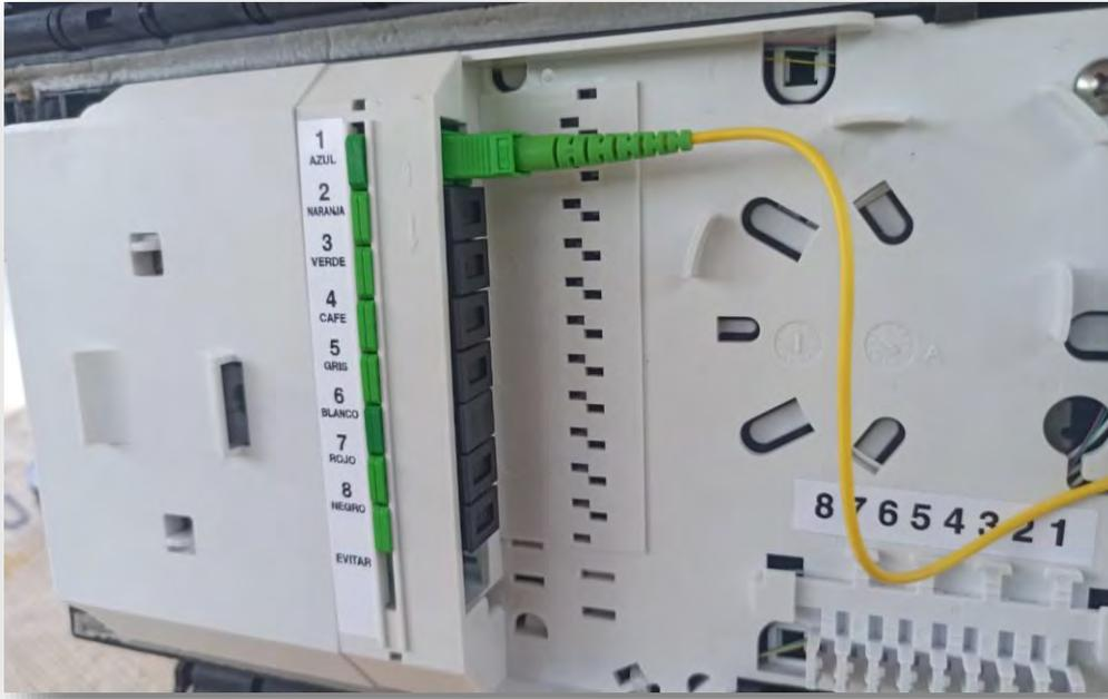
FIGURA 96(CONEXIÓN DE CABLE AL ACOPLADOR)
