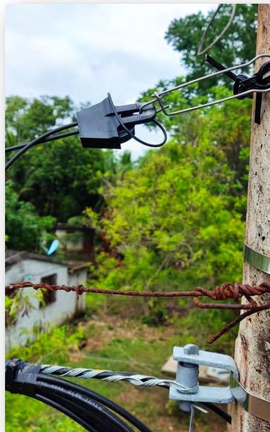
FIGURA 136(UNIFIBRA CON EL TENSOR EN EL POSTE)
