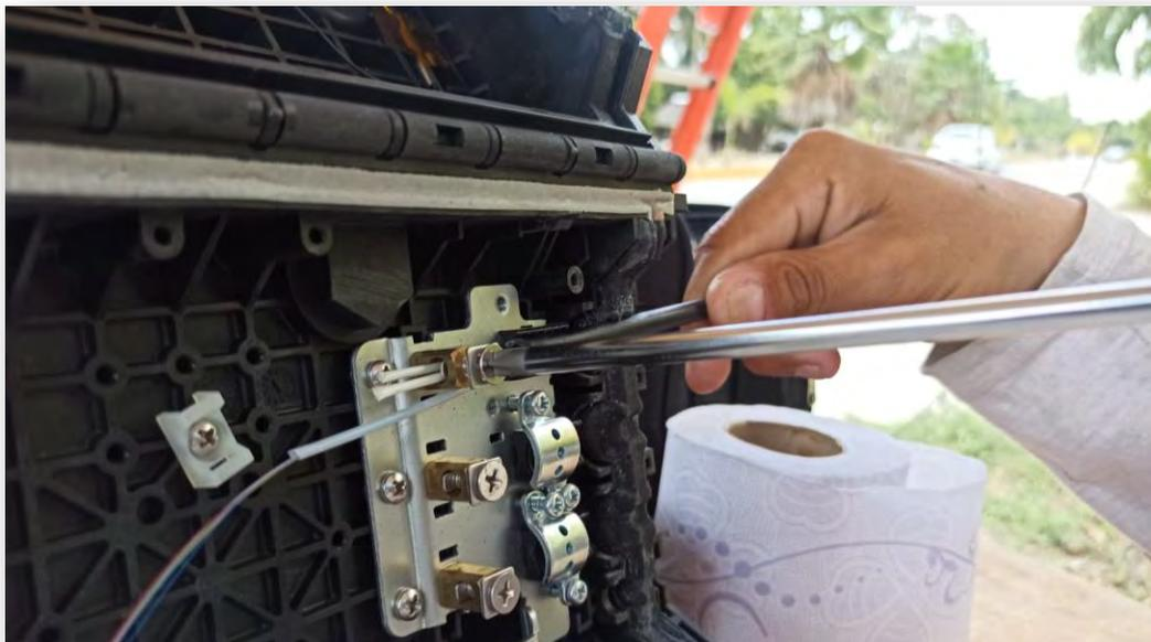
FIGURA 78(COLOCACION DE LA FIBRA EN LA CAJA DE DISTRIBUCIÓN PARTE 2)
