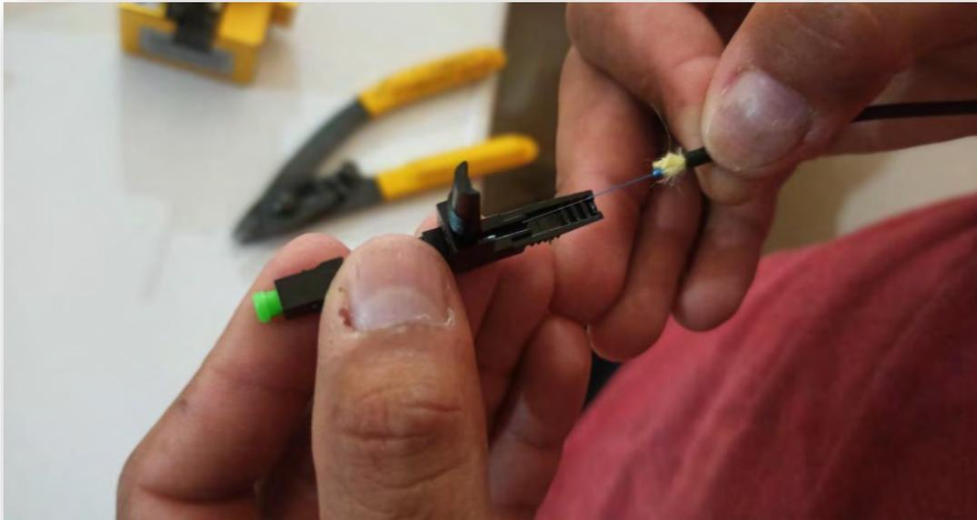
FIGURA 139(INSTALACIÓN DE CONECTOR DEL LADO DEL CLIENTE)
