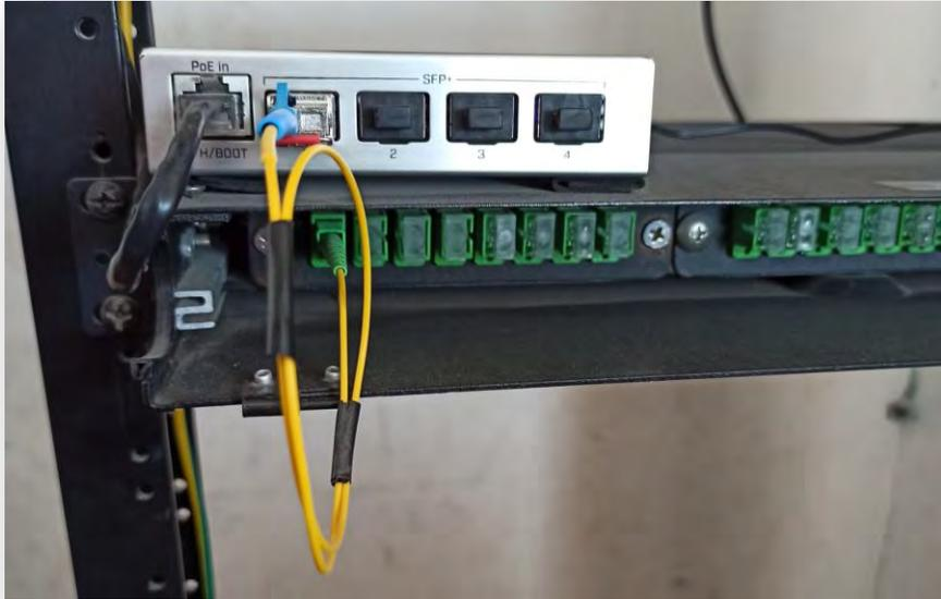
FIGURA 108(CONEXIÓN DE MICROTIK A UDF)
