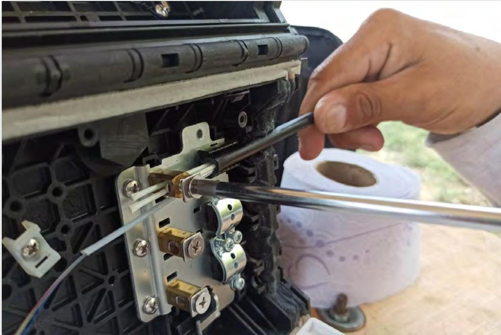
FIGURA 79(COLOCACION DE LA FIBRA EN LA CAJA DE DISTRIBUCIÓN)
