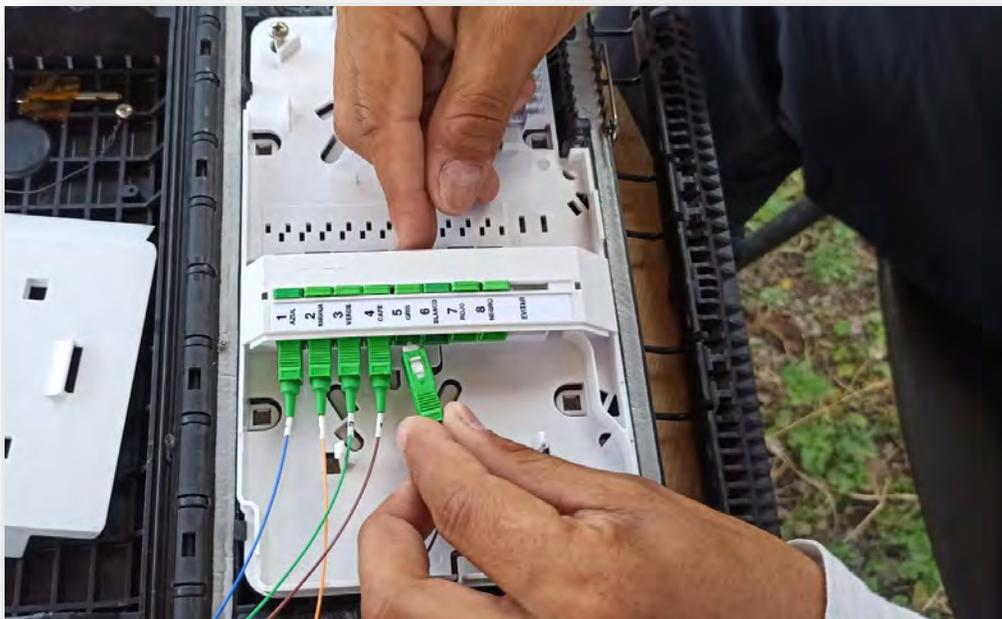
FIGURA 66(ACOMODO DE SPLITER EN ACOPLADORES)
