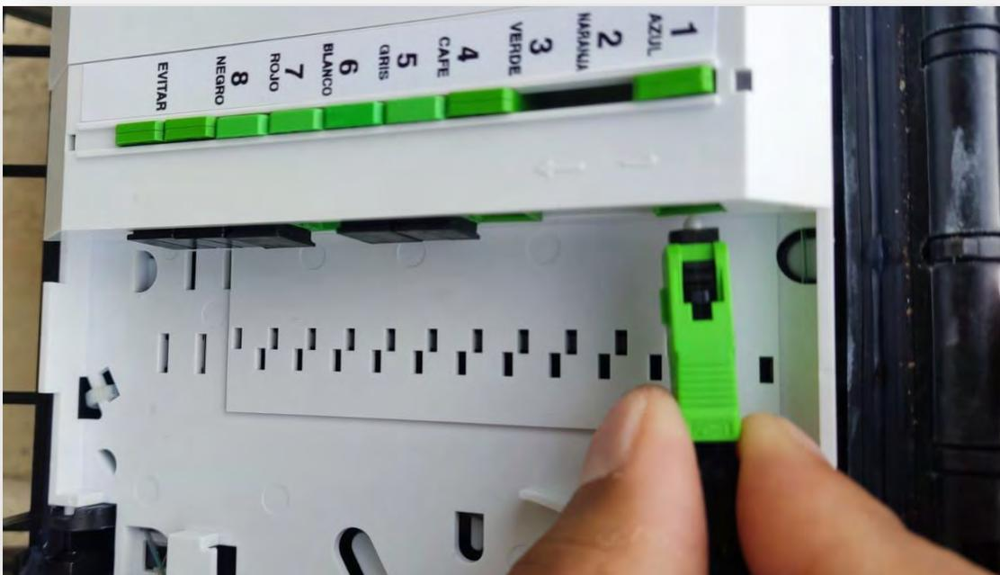
FIGURA 135(CONEXIÓN A LA CAJA DE DISTRIBUCIÓN 1)
