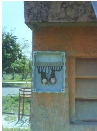
Figura 31. Fotografía del Registro de empalmes.
