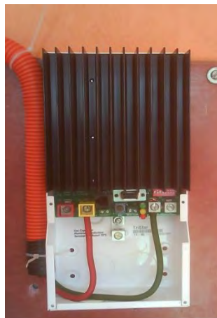
Figura 33. Fotografía de Conexión de cables Registro de empalmes – controlador.
