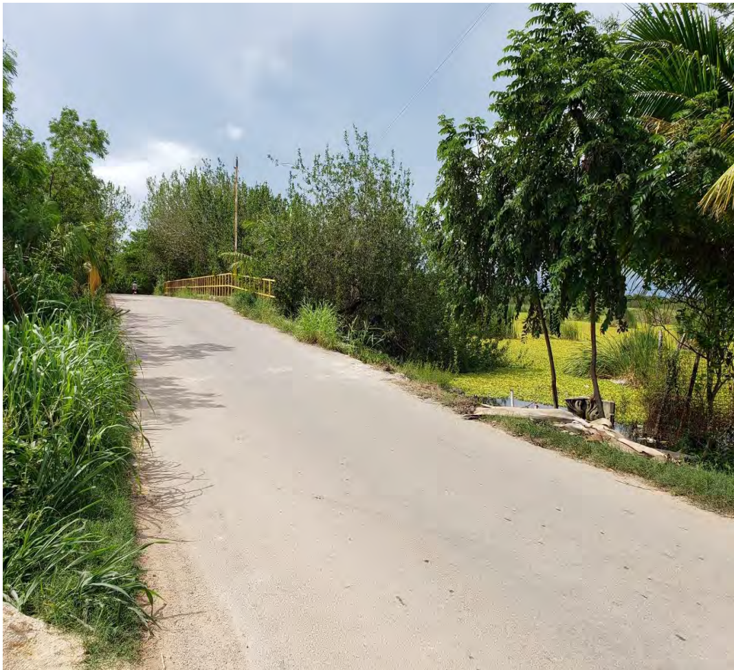
Figura 12. Puente construido sobre la Sabana Mártires de Antorchistas
