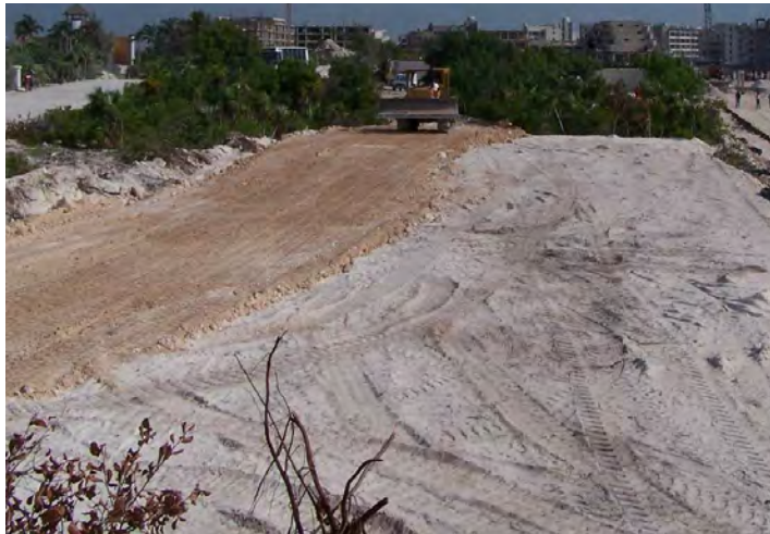
Figura IV.3. Acciones de nivelación
