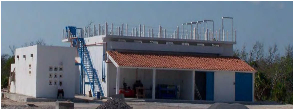
Figura IV.25. Módulo de la planta de tratamiento.
