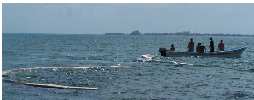
Figura IV.8. Colocación de la malla geotextil (Sección Norte).
