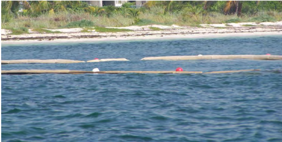
Figura IV.12. Malla geotextil en la proximidad Norte colindante con la playa.
