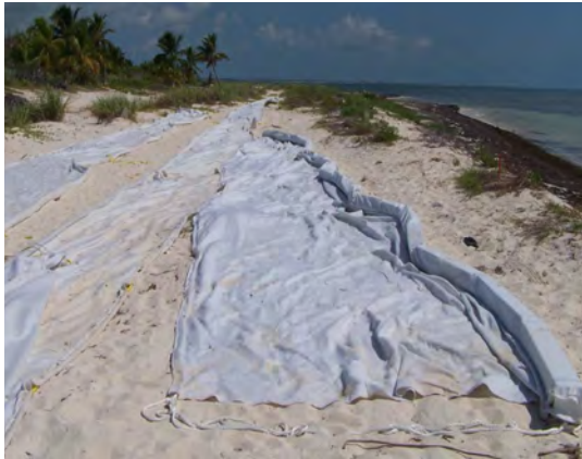
Figura IV.6. Preparación de las mallas geotextiles.
