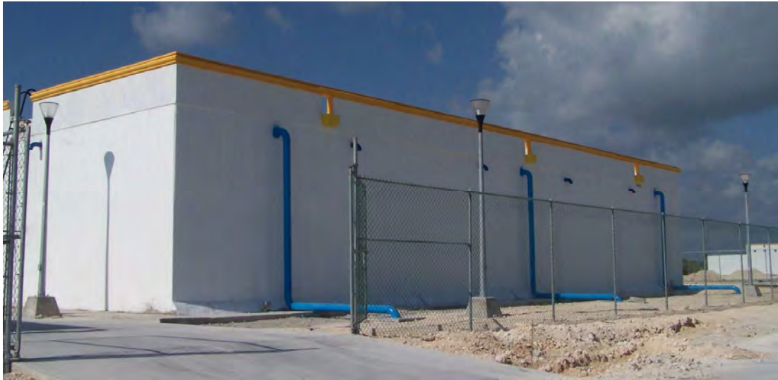
Figura IV.24. Planta de tratamiento de aguas residuales de playa mujeres.
