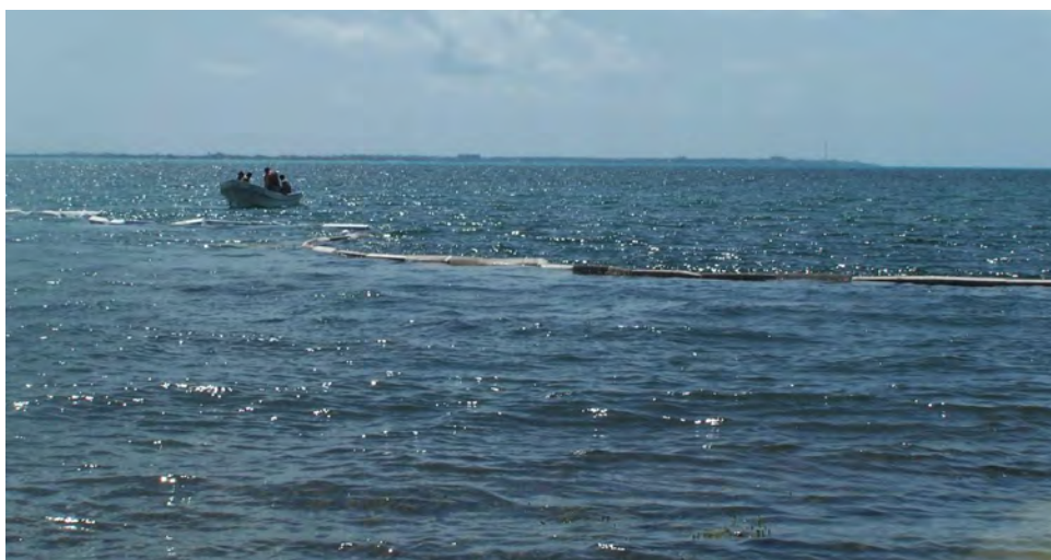
Figura IV.7. Colocación de las mallas geotextiles.
