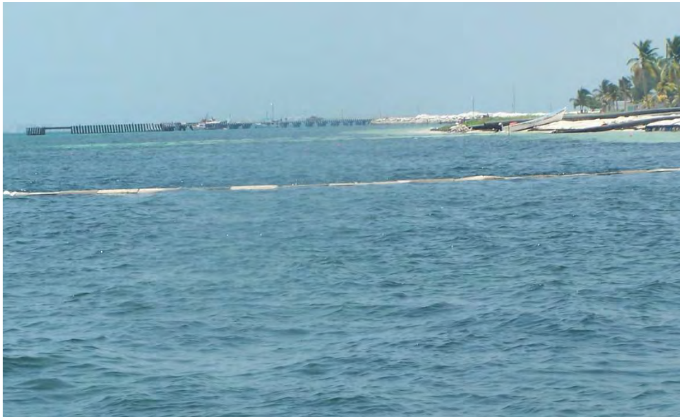
Figura IV.9. Malla geotextil dispuesta perimetralmente en la zona del dragado del canal de acceso. (Sección Sur)
