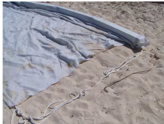
Figura IV.6. Preparación de las mallas geotextiles.
