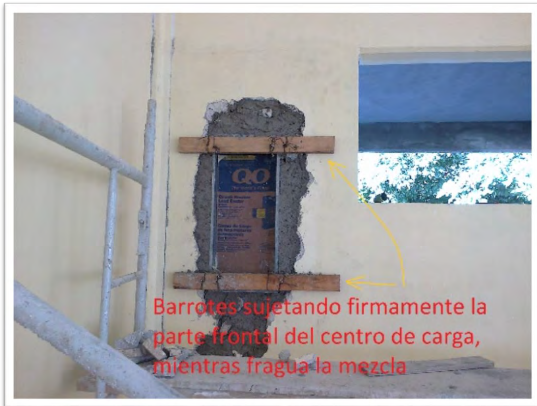
Figura 2.7. Fotografía de la instalación del centro de carga.
