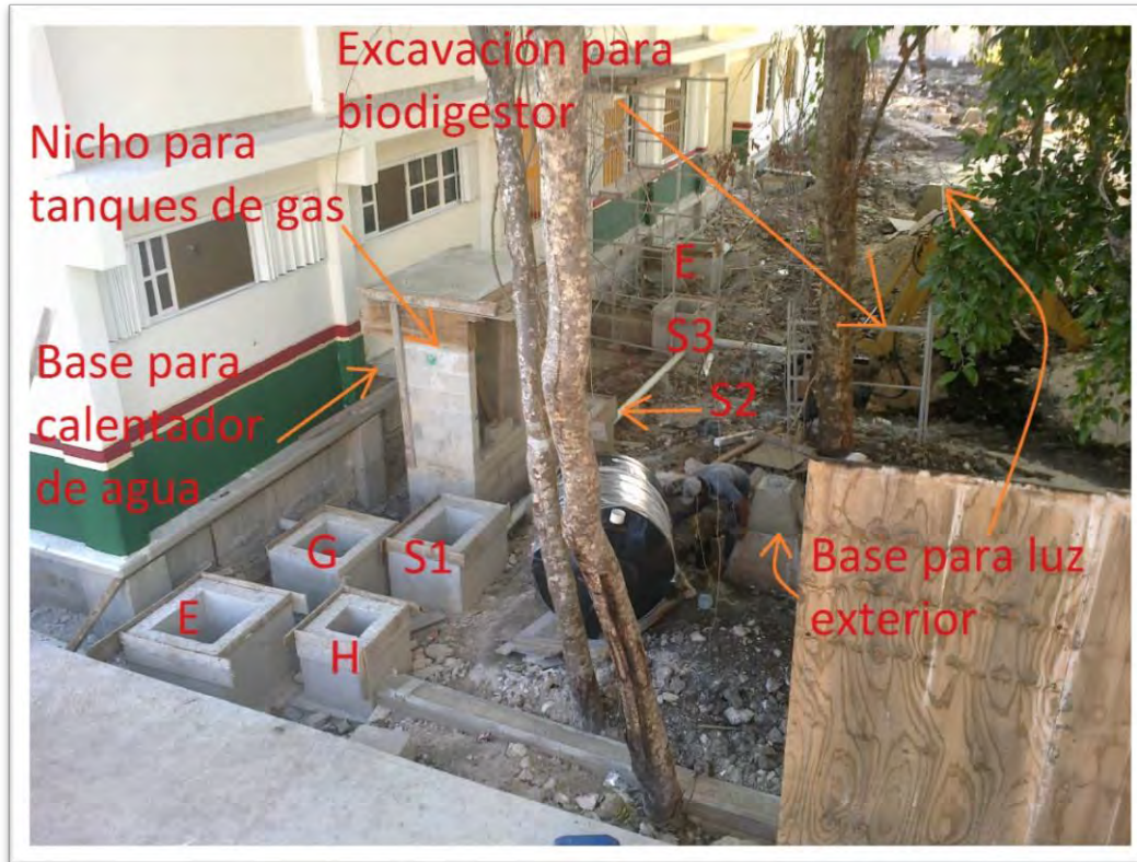
Figura 3.8. Fotografía de registros y preparaciones exteriores varias.
