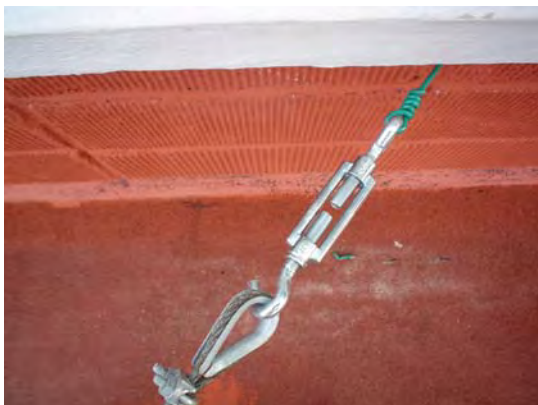
Figura 53. Ajuste de tensores en la pared con guarda cabos.
