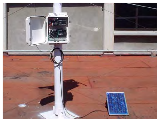
Figura 67. Instalación del modulo fotovoltaico al adquisidor de datos.
