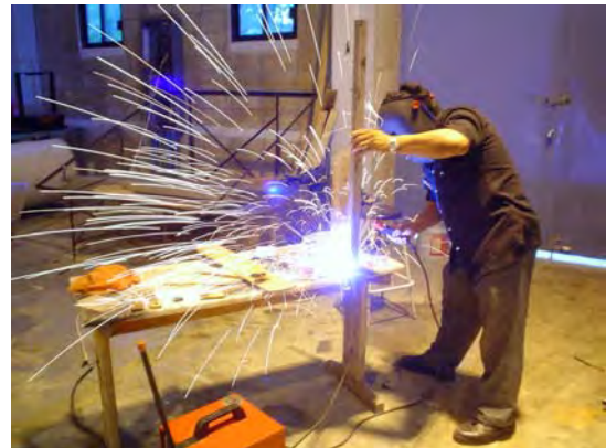
Figura 31. Proceso de soldadura de la columna con la placa.
