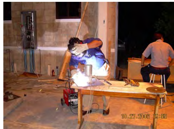
Figura 48. Soldadura de las tres piezas.
