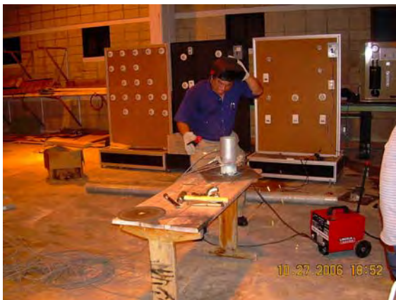
Figura 47. Preparación de soldadura para las tres piezas.
