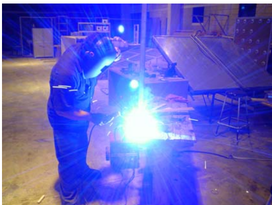
Figura 32. Soldadura de la primera placa sujetadora.
