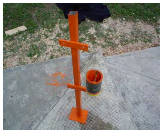
Figura 35. Aplicación de minio de plomo (pintura anticorrosiva).
