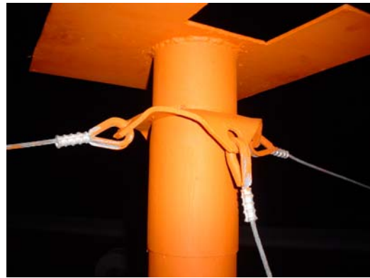
Figura 52. Ajuste de la placa de tensores al colocar la Base 2.
