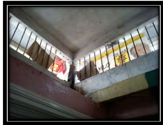
Fig. 42. Techo pasillo 1 con lonas.
