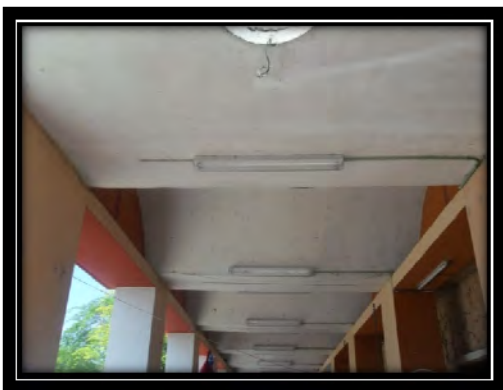
Fig. 7. Aluminado instalado en el área de pasillos exteriores del mercado.
