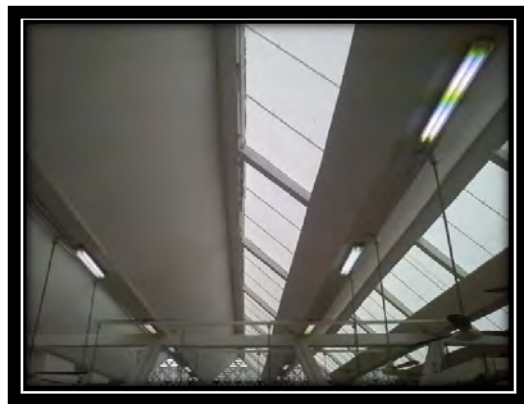
Fig. 6. Techo remodelado en el área de lonchería y ropa con láminas de policarbonato.
