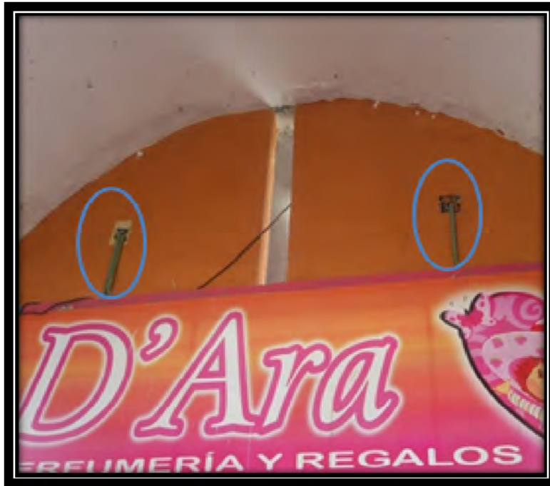
Fig. 17. Registros destapadas en el área de pasillos exteriores (lado de la Av. Héroes).
