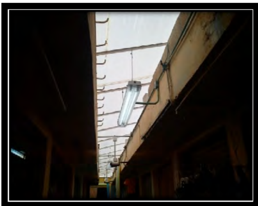
Fig. 5. Techo remodelado en el área de carnicería con láminas de policarbonato.
