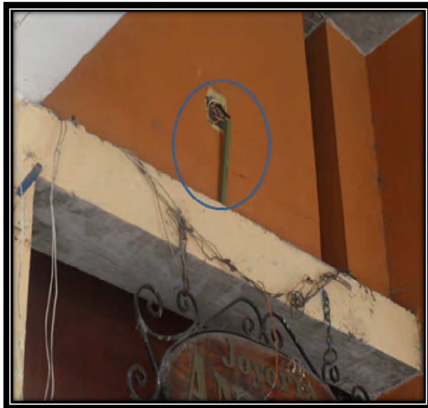
Fig. 18. Registros destapadas en el área de pasillos exteriores (lado la Av. Belice).
