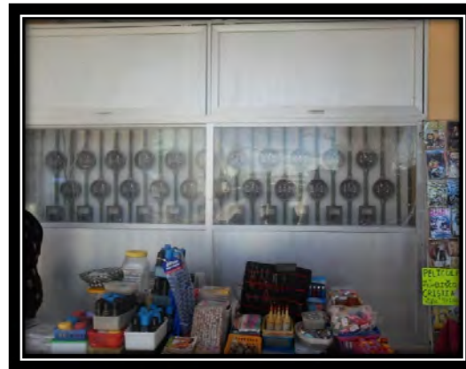
Fig. 14. Medidores de consumo de los locatarios y pasillos municipales. (Lado de la Av. Héroes).
