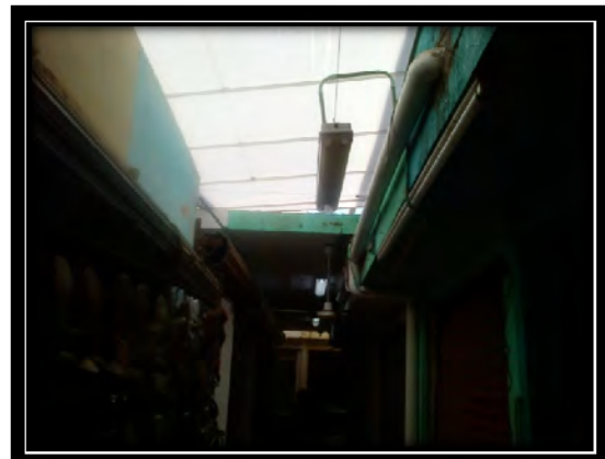
Fig. 40. Parte de techo sin tragaluz pasillo 4
