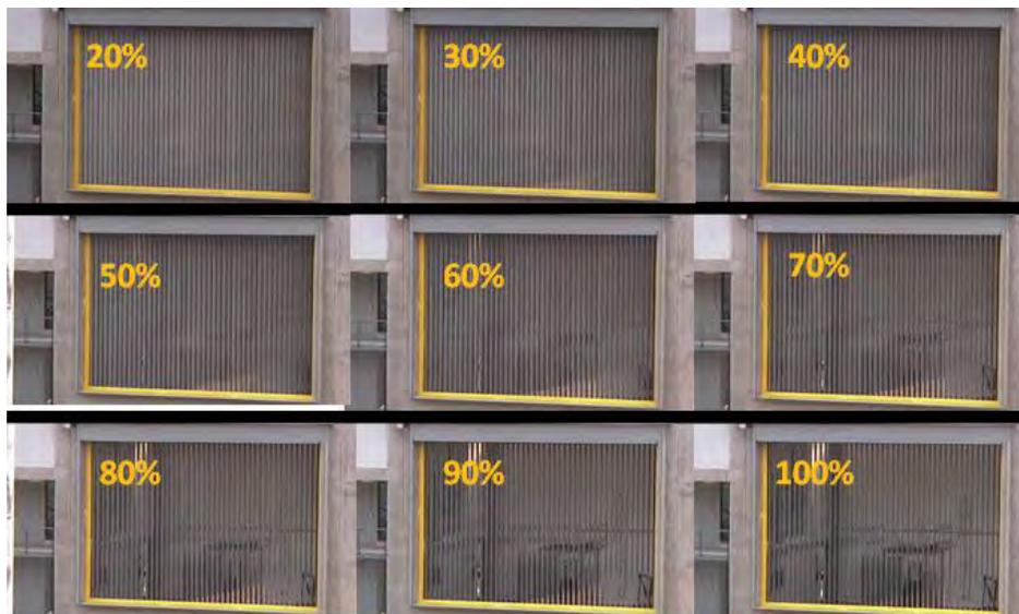
Ilustración 20; Atenuador en con diferentes porcentajes de abertura [11]
