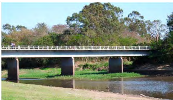
A: Puente San Fernando, Av. Sabín, Resistencia, Chaco.
