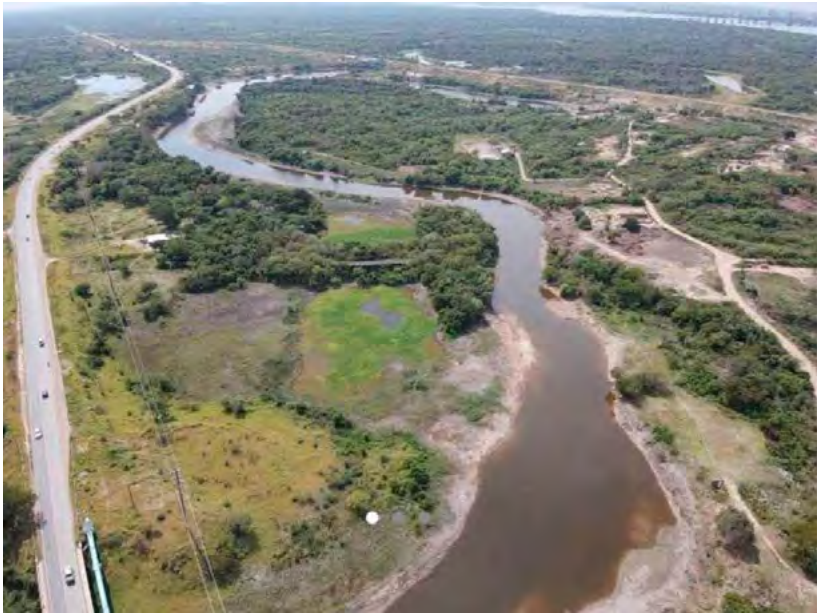
Figura 10: Subtramo 5, Puente de Av. San Martín, Barranqueras, Chaco.
