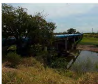
B: Puente de Av. San Martín, Barranqueras, Chaco
