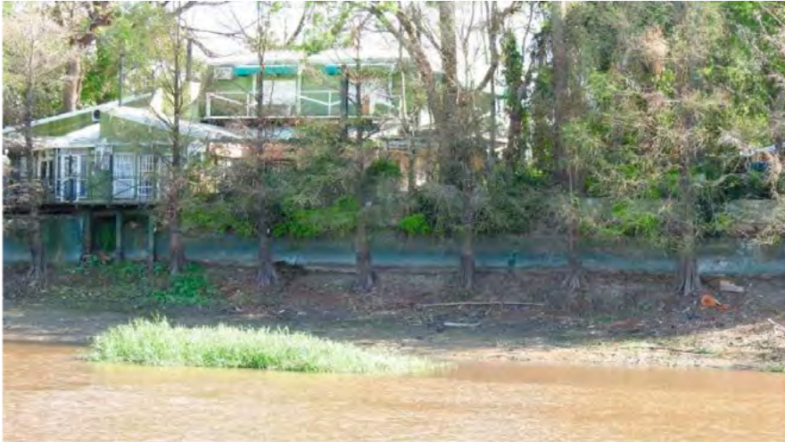
Figura 7: Estabilización de margen y protección contra inundaciones, Subtramo 3 (27°26'6.97"S- 58°58'53.25"O).
