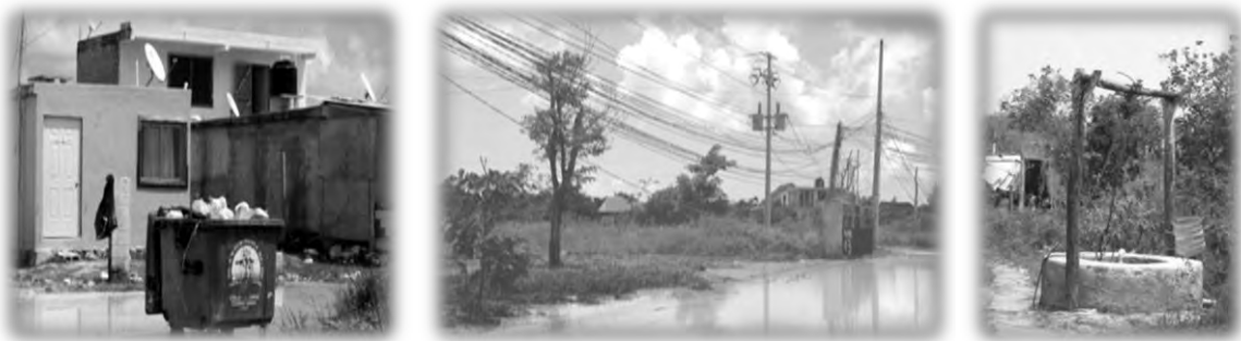
Figura 2. Condiciones en las que se encuentran las viviendas, los caminos e infraestructura urbana en el km. 55 de Mahahual, Quintana Roo
