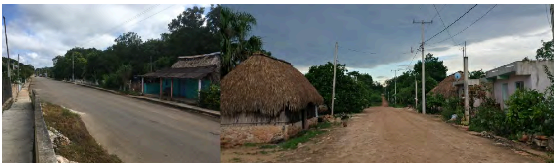
Figura 25 Pavimentación y ampliación de red eléctrica en Kantemó
