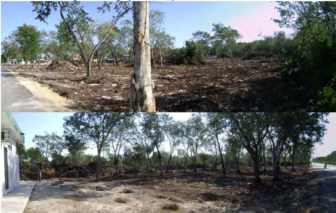
Imagen 1: Fotografías del despalme selectivo del terreno.
