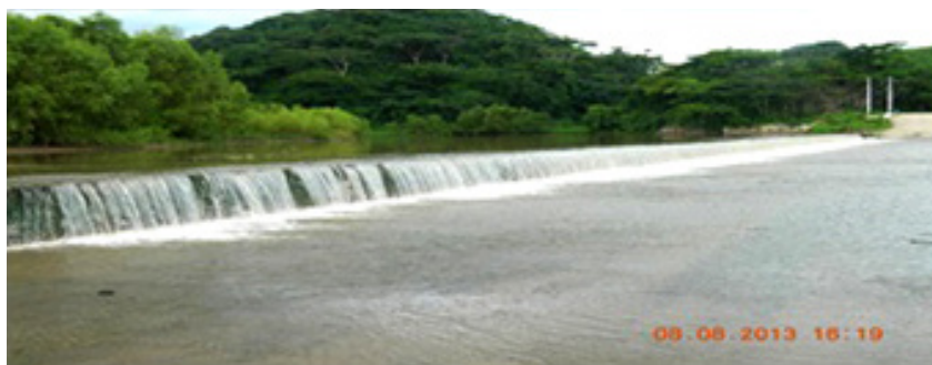
Figura 4. Cortina de la Presa
