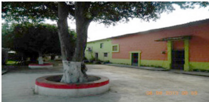
Figura 3. Exhacienda, fachada frontal
